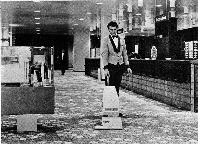
Mit dieser modernen Spezialmaschine für die Teppichreinigung, der Tiefsaug- und Florbürstmaschine Karpavel von Servo-Wetrol, wird der trockene Schmutz mit grosser Wirksamkeit aus dem Teppich herausgeholt. Das Zusammenwirken der Bürste mit dem starken Sauger ergibt die gewünschte Reinigungsleistung in die Tiefe des Flors. Die Karpavel ist die ideale Unterhaltsreinigungsmaschine für Teppichböden auch im Hotel- und Gastgewerbe. (Diethelm & Co. AG, Zürich)
