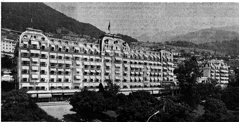
La nouvelle façade du Montreux-Palace et ses 230 stores automatiques. (Photo Germond)
