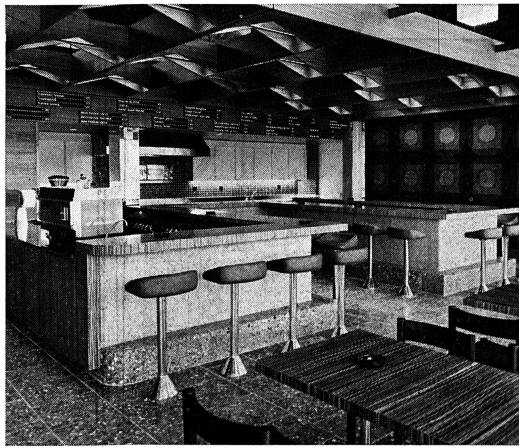
ESSO-Autobahn-Center Forrenberg. Links: Tankstelle, Shop und Teilsicht des Inter-Rest. Rechts: Kaffeebar im Restaurant.
