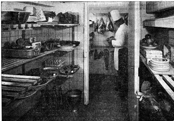
Fleischkühlraum und Kühlraum für den Tagesbedarf.
