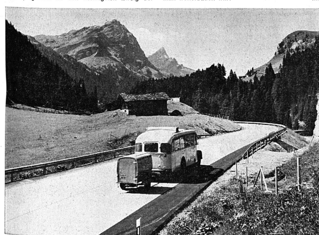
Der Bau der N 13 und die Eröffnung des San-Bernardino-Tunnels haben nicht nur im Rheinwald einen neuen Aufschwung verursacht, sondern dem Fremdenverkehr des ganzen Kantons Graubünden starke Impulse verliehen (N 13 zwischen Sufers und Splügen). (Photo Gensetzer)
