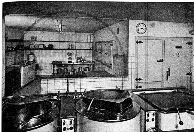
Kühlraum mit eingebauten Tagesabteilen, Freezer-Gracelange mit Konservator
