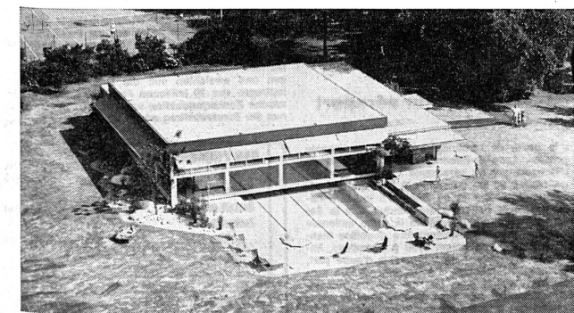
Sporting-Club Castello del Sole: Mitte Juli wurde in Asona das neue zum Hotel Sonnenhof gehörende Hallenbad eingeweiht. Technische Daten: Bassingröße 8 x 25 m, Entkeimung durch Ozonierung, nur teilweise Ueberdachung (Kombination mit Freibad). (Photo: F. Engesser)
