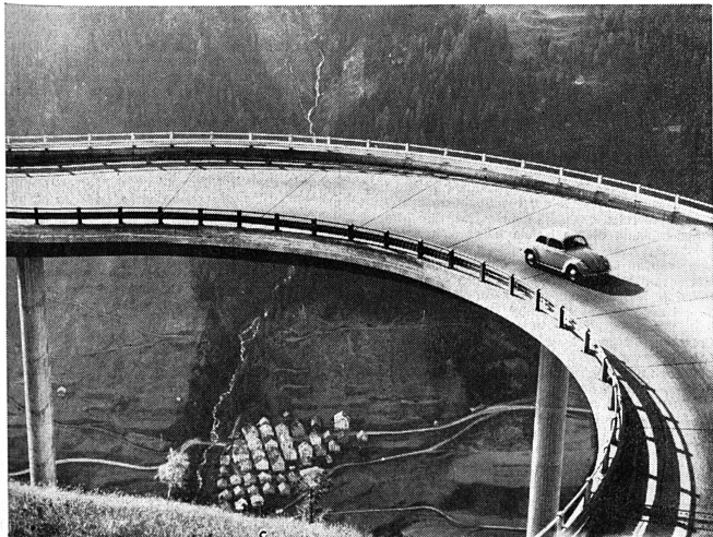
Atemberaubende Strassenbautechnik am neuen Teilstück der N2 oberhalb Airol. In der Tiefe Fontana im Bedretto.
