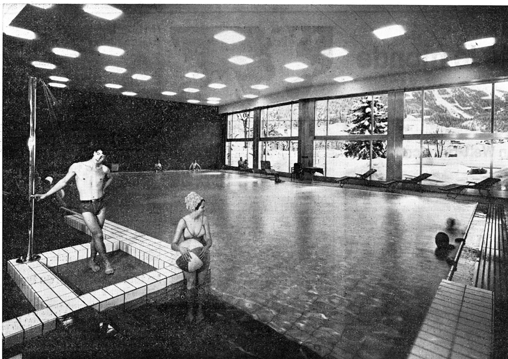
Das architektonisch grosszügig angelegte Hallenschwimmbad im Hotel Pardenn Klosters. Die Fenster können während der Sommerszeit automatisch geöffnet werden.
