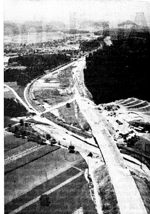
Baufortschritte an der N 1:
