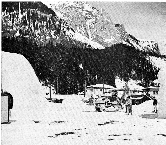
Kunsteisbahn-Baubeginn in Kandersteg:
