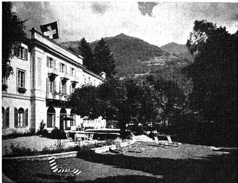
Frontansicht des Hauses von der Seeseite.
