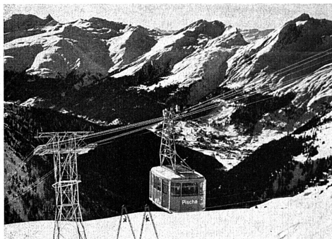
Die Kabinen der Pischabahn fassen je hundert Personen. Im Talgrund der Kurort Davos. Rechts das berühmte Schilhorn, links davon das Strelagebiet.
