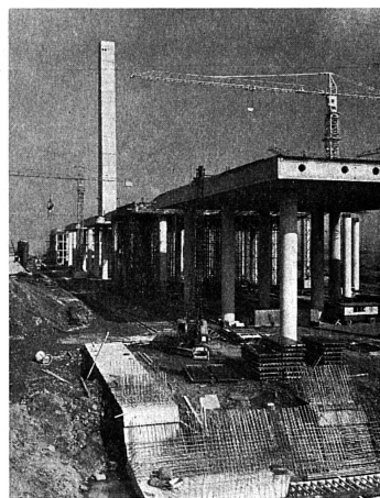
Tour de la tête amont Pont-canal en cours de bétonnage.
