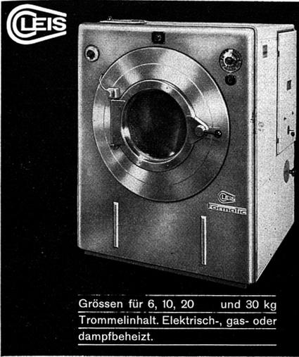
Größen für 6, 10, 20 und 30 kg Trommelinhalt. Elektrisch-, gas- oder dampfbeheizt.
