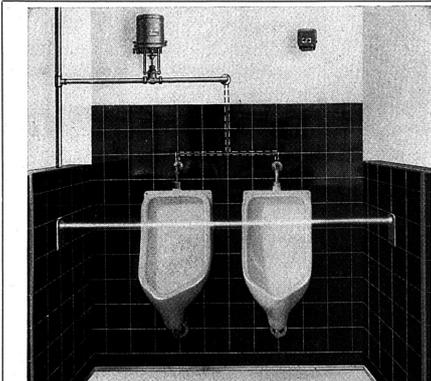
In sanitären Anlagen ist es aus hygienischen Gründen wünschenswert, dass die Steuerung automatisch und berührungslos erfolgt. Eine ideale Lösung für diesen Zweck ergibt die Verwendung der Elesta-Lichtsteuerung Type LS 105 A in Kombination mit einem Magnet- oder Motorventil.
