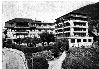
... nach dem Umbau
