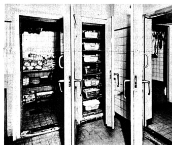
5 Fleischkühlräume für grösseren Betrieb mit Vorraum und Hauptraum rechts, Schrank für vorbereitete Ware in der Mitte und Raum für Wurstwaren links; gute Raumaussnutzung
