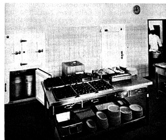
4 Kalte Küche in grossem Betrieb mit gut unterteilten Kühlschränken für Handvorräte und ebensolchen Kühlräumen für länger lagernde Lebensmittel
