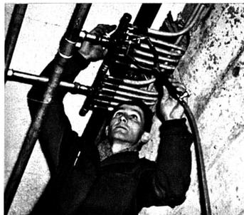
Kupferrohrventile für ein Einzelzapfstellensystem
