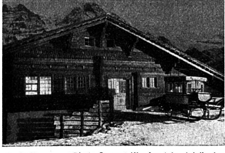
Nordseite Photo Gyger & Klopfenstein, Adelboden
