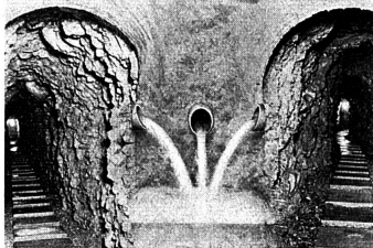
Blick auf die Quelle Henniez-Lithinée SA. Das Mineralwasser wird in unterirdischen Galerien gesammelt; dadurch wird jedes Durchsickern von Oberflächenwasser verhütet.
