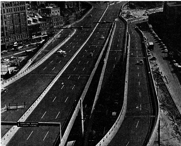
Voies d'accès et de sortie d'une Expressway citadine. Celle-ci a été aménagée au-dessus des petites rues étroites de Boston (Massachusetts).
