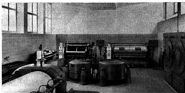
Wäschereianlage Stadtspital Waid Zürich
