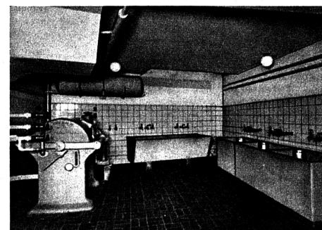
Trommelwaschmaschine mit Unterfeuerung durch Gasbrenner
