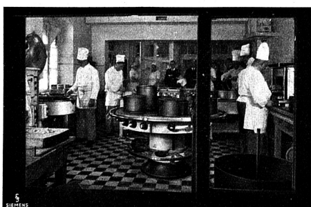
Moderne elektrische Küche für „Hotel am Zoo“ und Restaurant Kurfürstenteller in Berlin, 1937. Vom Büro des Küchenchefs aus gesehen; im Hintergrund die Restaurant-Ausgabe. Anschlusswert 134 kW.
