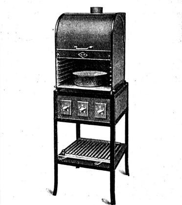
Elektrischer Grill-Salamander mit eisernem Tisch und eingebauten Schaltern
