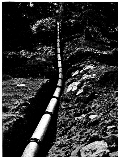
Druckleitung aus Eternit
