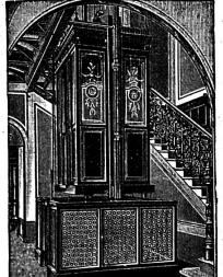
Hydraulische Warenaufzüge, Hydraulische Gepäckaufzüge, Hydraulische Speiseaufzüge, Transmissionaufzüge.
