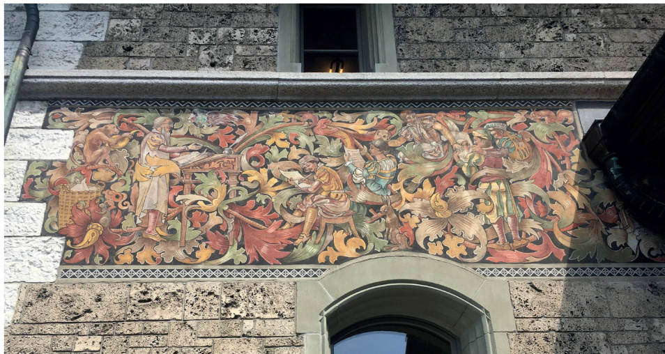
Abb. 2. Landesmuseum Zürich, gemalter Fries unterhalb der Dachlinie über der Terrasse des früheren Kunstgewerbeflügels am Eingangshof. Die Ranken mit verschiedenen Tieren sind von spätgotischen Flachschnitzereien abgeleitet und integrieren hier eine Szene aus dem Unterricht an der Kunstgewerbeschule, historisierend mit Kleidung des 16. Jahrhunderts dargestellt. Fotografie: C. Gutbrod, 2023.
