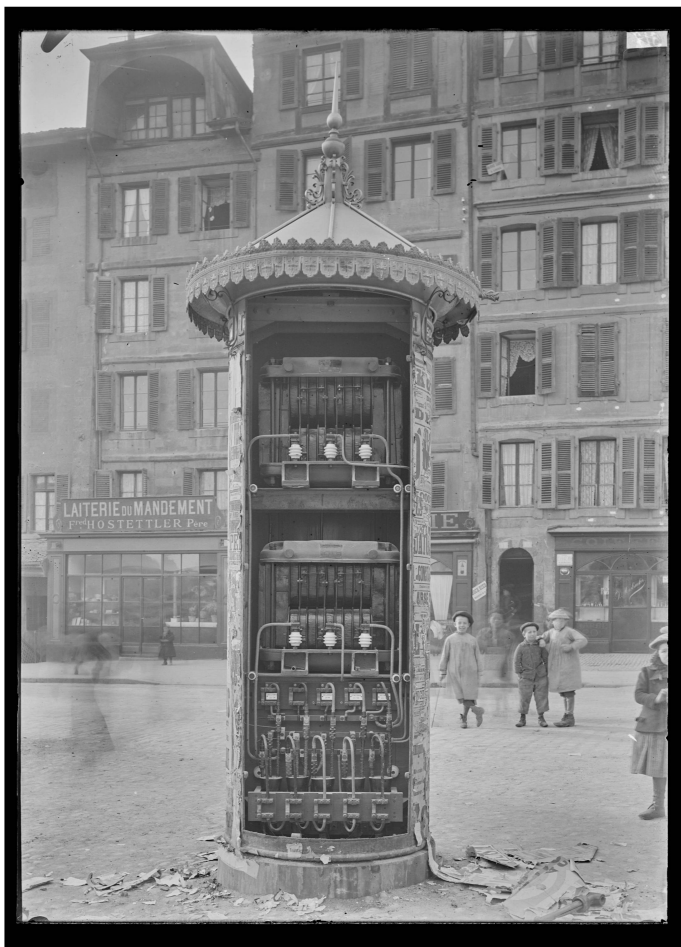
Fig. 2. Transformateur électrique à la place St-Gervais, 1905. Bibliothèque de Genève / Centre d'iconographie genevoise, SIG n13x18 00317.
