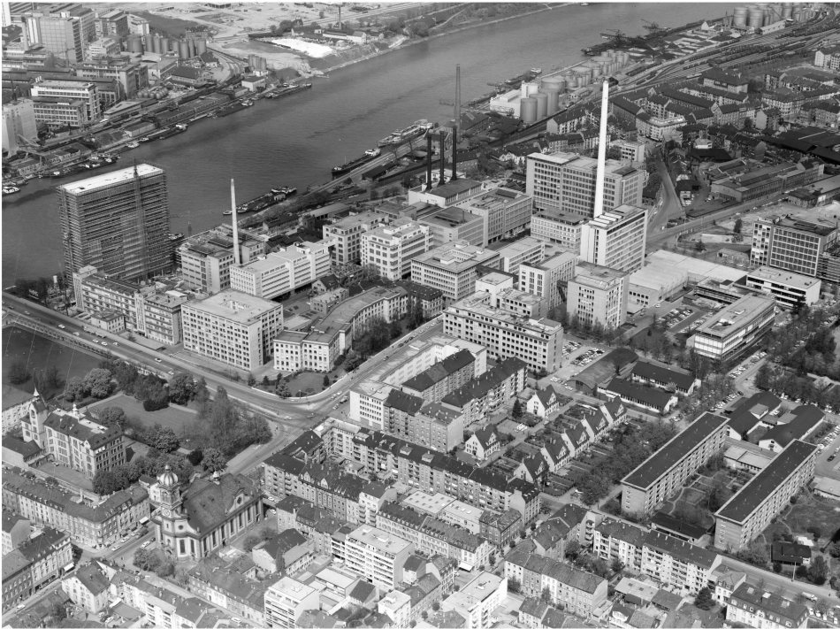
Abb. 7. Basel, Ciba-Geigy, Blick nach Nordwesten mit überformtem Verwaltungsgebäude durch das Architekturbüro Suter & Suter, Fotograf: Werner Friedli, 1965. © ETH-Bibliothek Zürich, Bildarchiv / Stiftung Luftbild Schweiz / LBS_ H1-025944 / CC BY-SA 4.0 / Public Domain Mark.
