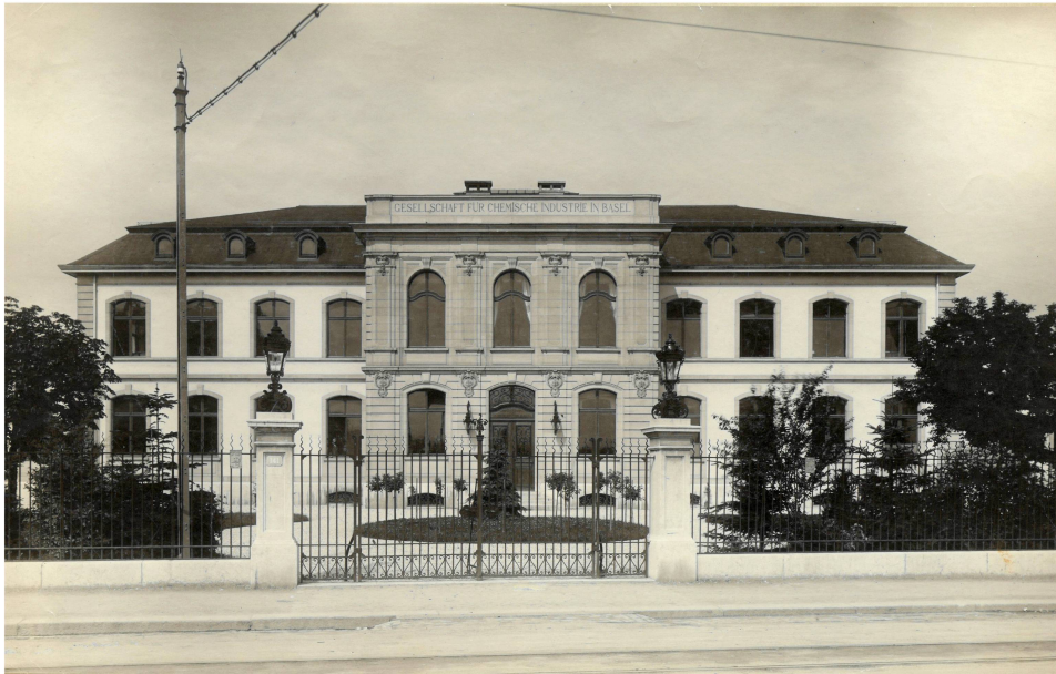
Abb. 4. Basel, Verwaltungsgebäude der Gesellschaft für Chemische Industrie Basel, Fritz Stehlin, 1905–1915. © Novartis-Archiv, Bestand Ciba, T 1.01.3.
