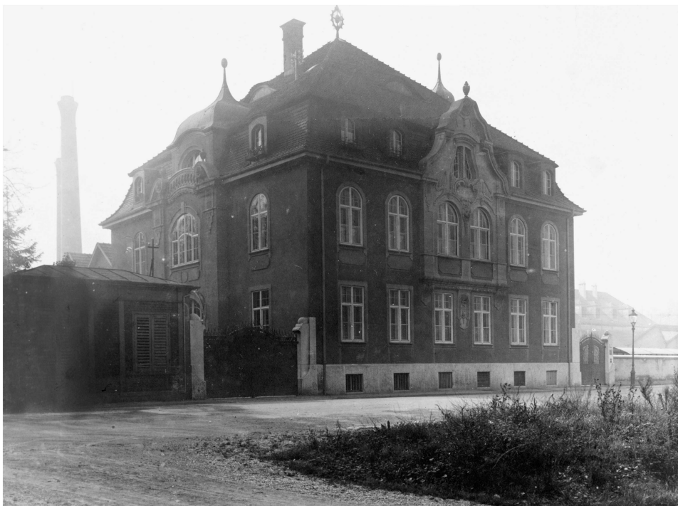
Abb. 2. Basel, Bau 1 , die sog. Villa Blume , Verwaltungsbau des F. Hoffmann-La Roche & Co. Pharmaunternehmens , Romang & Bernoulli, 1904/1905 © Roche-Archiv, HAR PH.1.11-500069.
