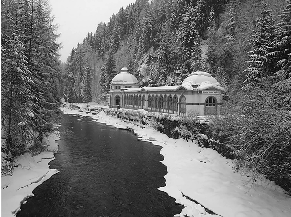
Abb. 3. Scuol, Büvetta Kurhaus Tarasp. © Foto Denkmalpflege Graubünden.
