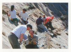
In einem abgerutschten Hang bei Langwies (GR) werden Erlenzweige gesteckt. Diese schlagen von selbst aus und befestigen mit ihren Wurzeln den Hang. So werden Strasse und Bahnlinie nach Arosa geschützt. (Foto: Urs Küng)
