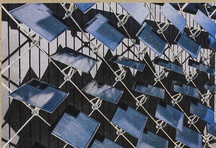
Wie eine Sonnenblume: Die beweglichen Fotovoltaikelemente richten sich nach der Sonne aus.
