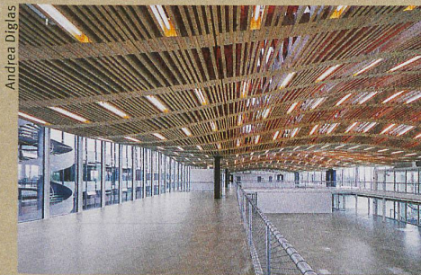
Das Holzdach des Arch-Tec-Lab der ETH wurde programmiert und von Robotern konstruiert.
