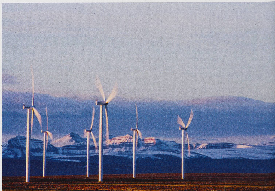
Gilt auch in Wyoming (USA): Der ideale Abstand zwischen Windrädern in Windrichtung beträgt achtmal die Turmhöhe. Bild: Keystone/Aurora/Chris Noble
