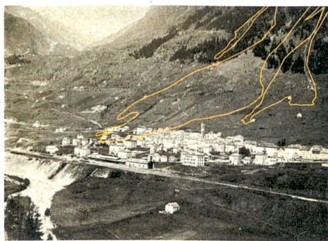
Vielgestaltiges Ereignis: Foto des Erdbebens bei Airolo von 1898 (oben). Daraus ist auf die Ablagerungszone vor dem Rutsch zu schliessen (links), die ferner auf eine aktuelle Pixelkarte (unten rechts) und eine Orthofoto (unten links) aufgetragen wird.
