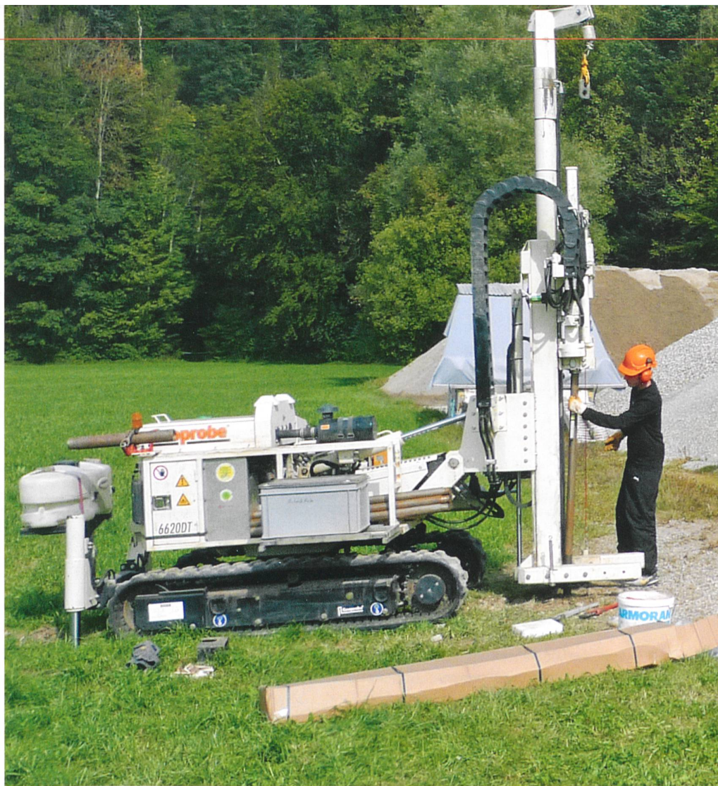
Bohren fürs Grundwasser: Installation einer Drucksonde im Emmental. Bild: eawag.ch & chyn.ch
