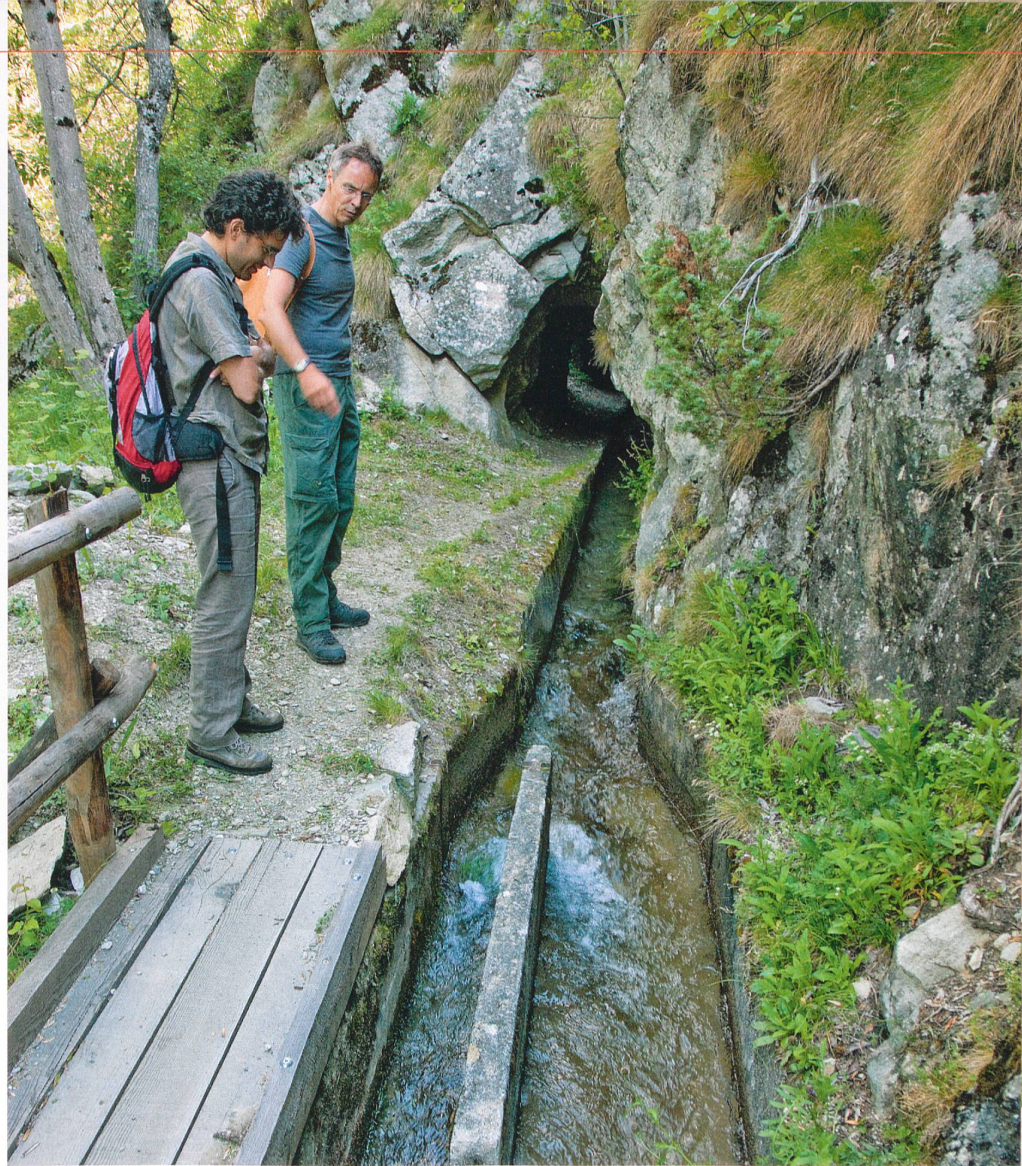
Traditionelle Bewässerung im Wallis: Die Suone «Grossa» oberhalb Birgisch (linke Seite). Oben eine Barriere, die nicht mehr in Gebrauch ist, rechts ein Wasserteiler. Seite 10: Zuerst wird die Suone gestaut, dann die Wiese berieselt.
