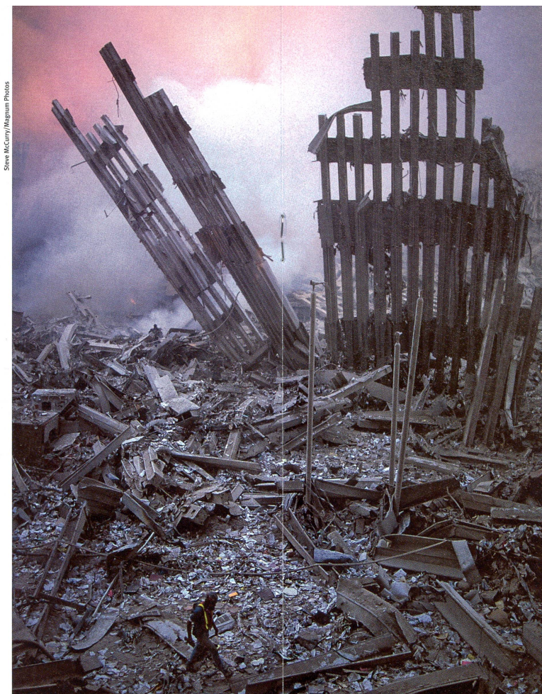
Oben: Nach dem Einsturz der Twin Towers im September 2001. Unten: Grossbrand in Steinhausen 2007. Wie instabil Stahlträger bei grosser Hitze werden, kann ein Ingenieurteam der ETH Zürich zum Teil theoretisch berechnen. Die Forscher stützen sich aber auch auf Experimente (unten rechts: Beulversuch in der grossen Versuchshalle der ETH Höggerberg) oder auf Erfahrungen aus simulierten Grossbränden (unten links: Stahlstütze nach einem Naturbrandversuch in einem achtstöckigen Gebäude im englischen Cardington).
