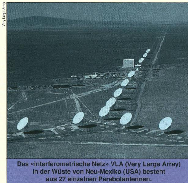
Das «interferometrische Netz» VLA (Very Large Array) in der Wüste von Neu-Mexiko (USA) besteht aus 27 einzelnen Parabolantennen.
