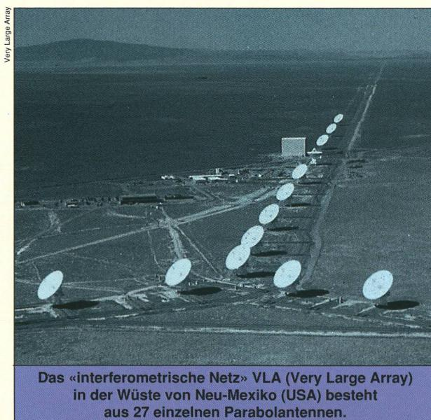
Das «interferometrische Netz» VLA (Very Large Array) in der Wüste von Neu-Mexiko (USA) besteht aus 27 einzelnen Parabolantennen.
