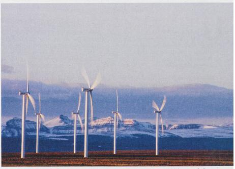
Parc éolien dans le Wyoming. Des simulations montrent que la distance idéale entre éoliennes dans la direction du vent est de huit fois la hauteur du mât. Image: Keystone/Aurora/Chris Noble
