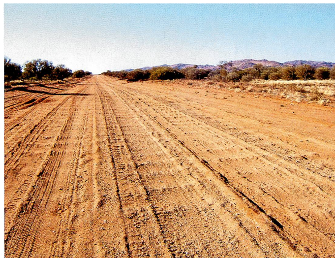
Les rides qui se forment sur les routes non goudronnées (à droite) peuvent être dangereuses. Les chercheurs ont utilisé une table tournante recouverte de sable pour étudier ce phénomène (ci-dessus). Photo à gauche: Nicolas Taberlet, photo à droite: Graham Nicholls
