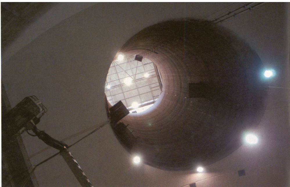
Un des orifices par lesquels sont descendus les éléments du détecteur ATLAS.
