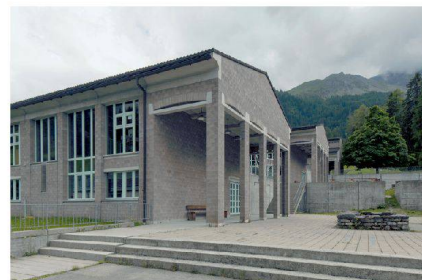
Auf der Südseite der Kreisschule in Churwalden stehen Portiken tempelartig vor dem kaskadenhaft gestaffelten Baukörper.
