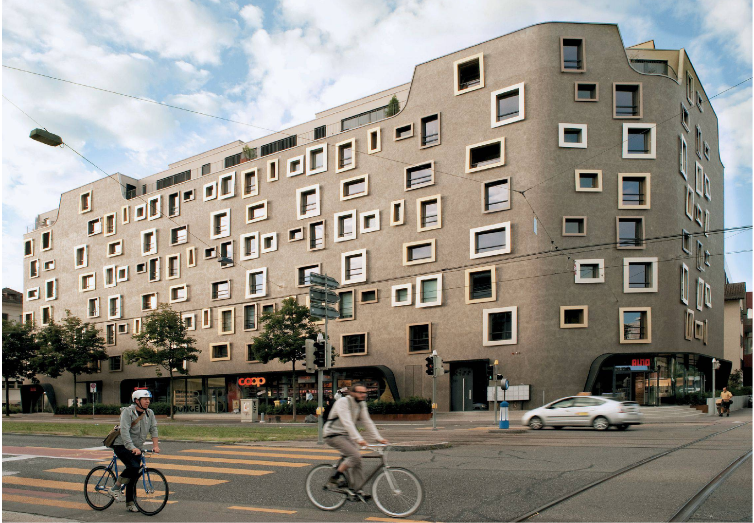
^Bildhaft: Die strassenseitige Fassade mit unterschiedlich grossen Lochfenstern kaschiert Laubengänge und Nasszellen.
