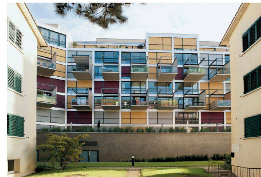
^ Rückseite: Wohnräume hinter verglaster Fassade.
