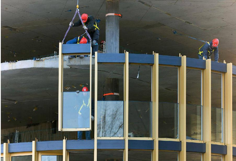
^Montage am Abgrund: Die Bauarbeiter platzieren die Fenster ohne Gerüst.
