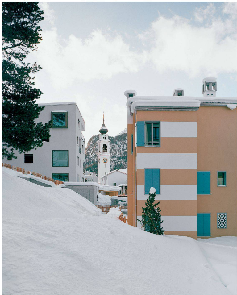
↳ Blick vom Hof: rechts der neue Anbau der Chesa Melna, links das Ende einer Überbauung von Hans-Jörg Ruch.
