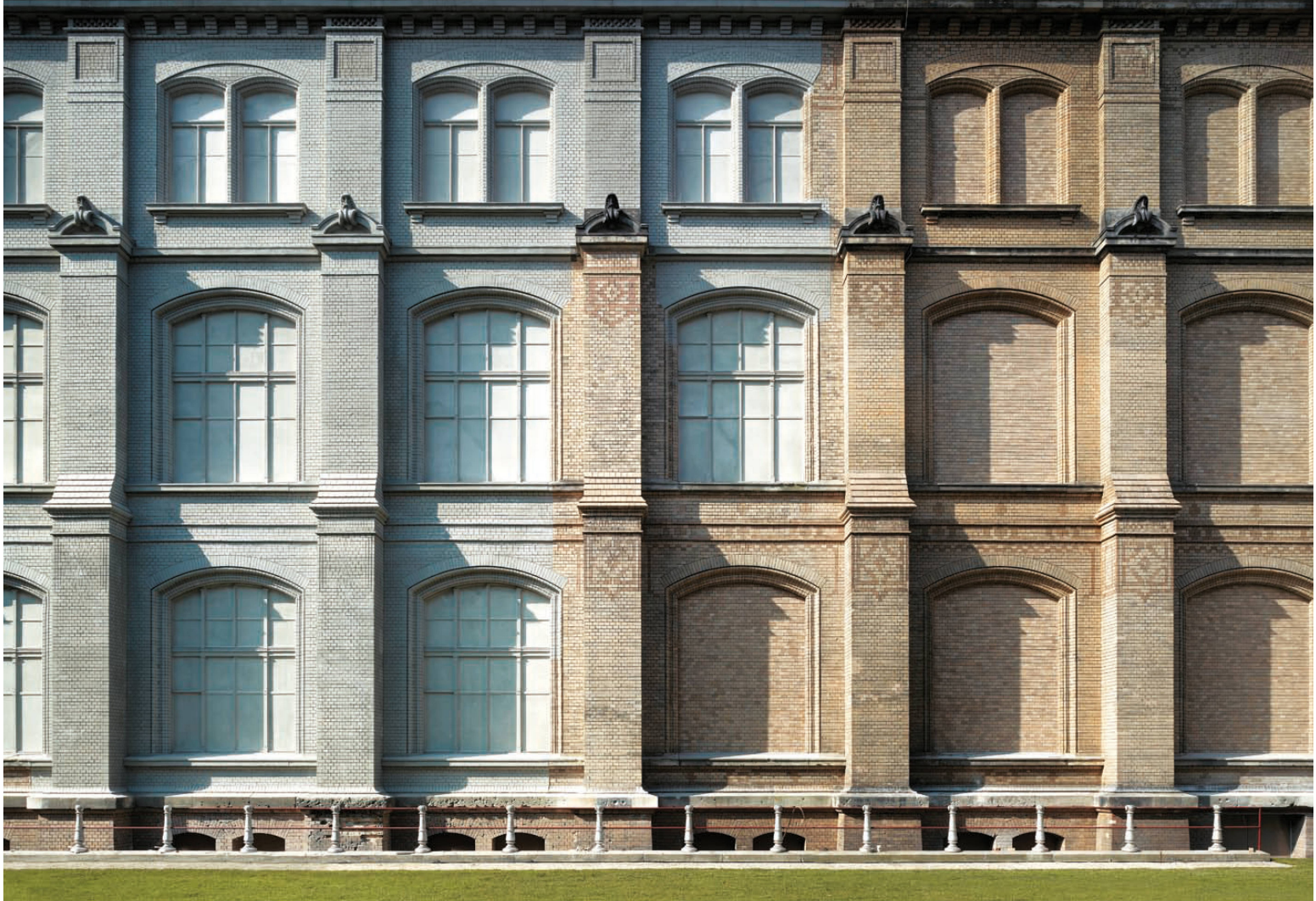
^Die letzte Evolutionsstufe der Rekonstruktion: ein Abguss aus Beton.
