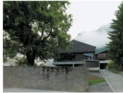
^8_Flims: Wo der Stall aus Holz war, steht das Atelier aus Beton. Architektur: Valerio Olgiati, Foto: Archive Olgiati
