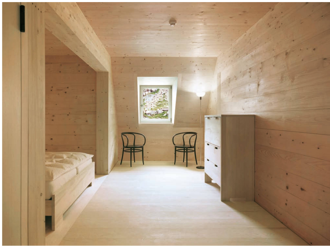
^Das massive Ständerwerk des Hauses gliedert die Zimmer.
